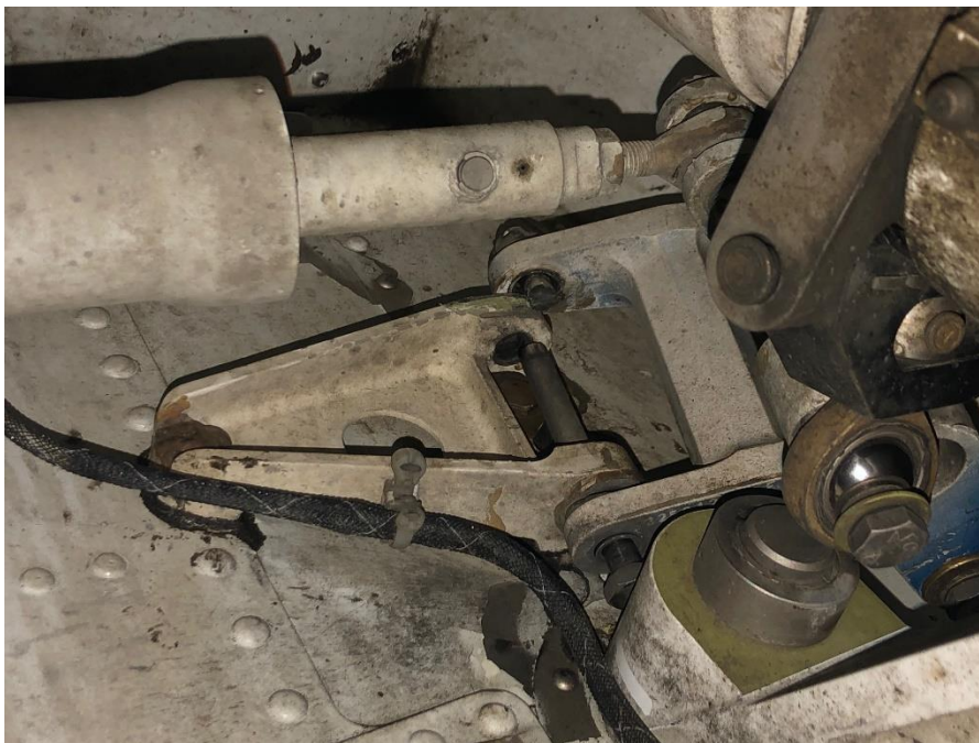
Photo 1 : Boulon cisailé dans l'assemblage
